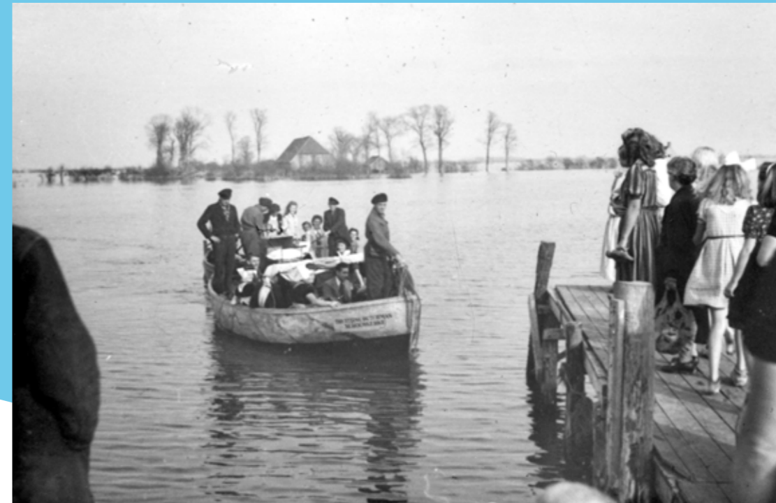
Aanlegsteiger te Grijskerke voor het veer Middelburg-Domburg tijdens de inundatie van Walcheren, 1944-1945. De loopsteiger vormde een verbinding tussen de Domburgse watergang en de kom van het dorp. De vaarroute was aangegeven met gevlochten fruitmanden hangende aan de zogenaamde Rommelasperges. De 'veerboot' bestond uit een reddingsboot voortgetrokken door een motorbootje. Foto: A.G. Kruithof (1894-1983). Zeeuws Archief, Fotoarchief A.G. Kruithof, nr 36.
