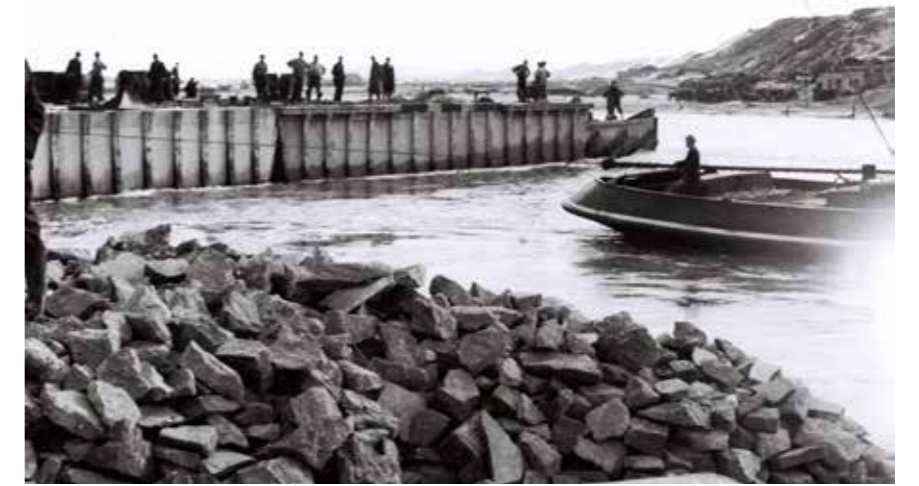
Een intermediaire-ponton wordt ingevaren in het sluitgat bij Westkapelle. Verzameling N. Flipse-Roelse, nr 610 NFR
